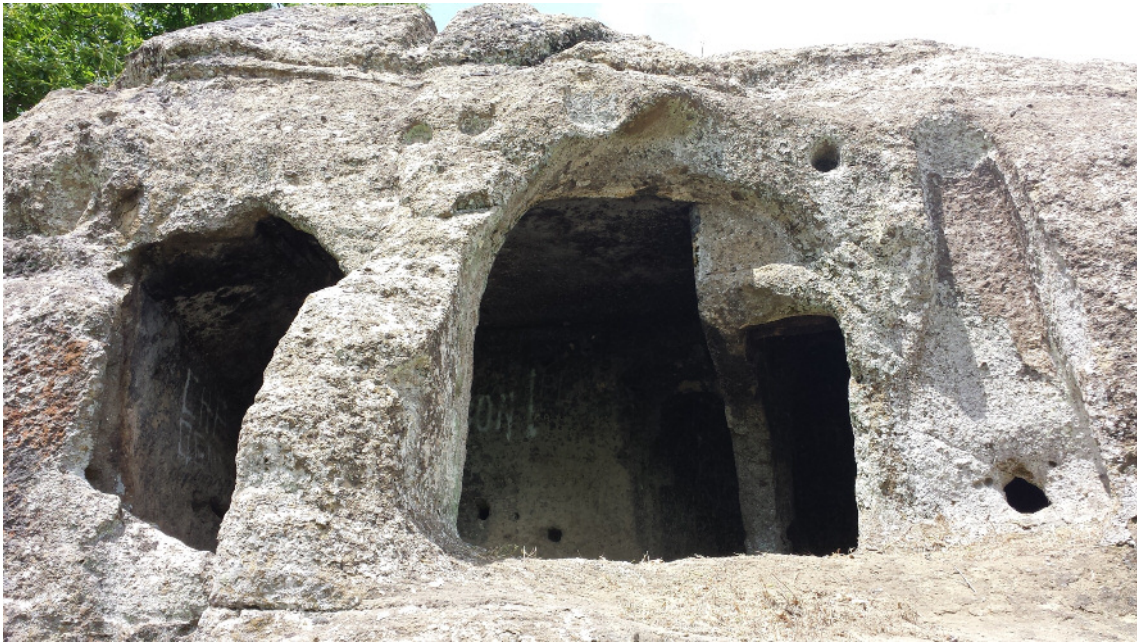
Fig. 1 - Parete esterna di S/O degli ambienti A e B ; in alto è evidente una canalina per il deflusso delle acque piovane e delle buche circolari per pali lignei, probabilmente atti a sostenere una tettoia. Mentre a destra, in quello che è il prospetto esterno dell' ambiente B , è visibile il residuo della canna fumaria del forno che è stato datato tra IX-X sec.
