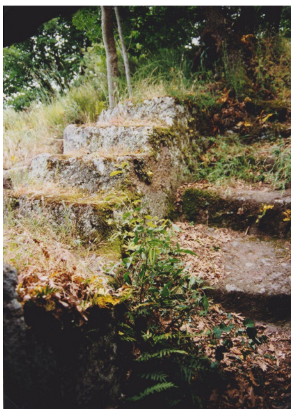
Fig. 10 - Corviano (Soriano nel Cimino), particolare dei gradini.
