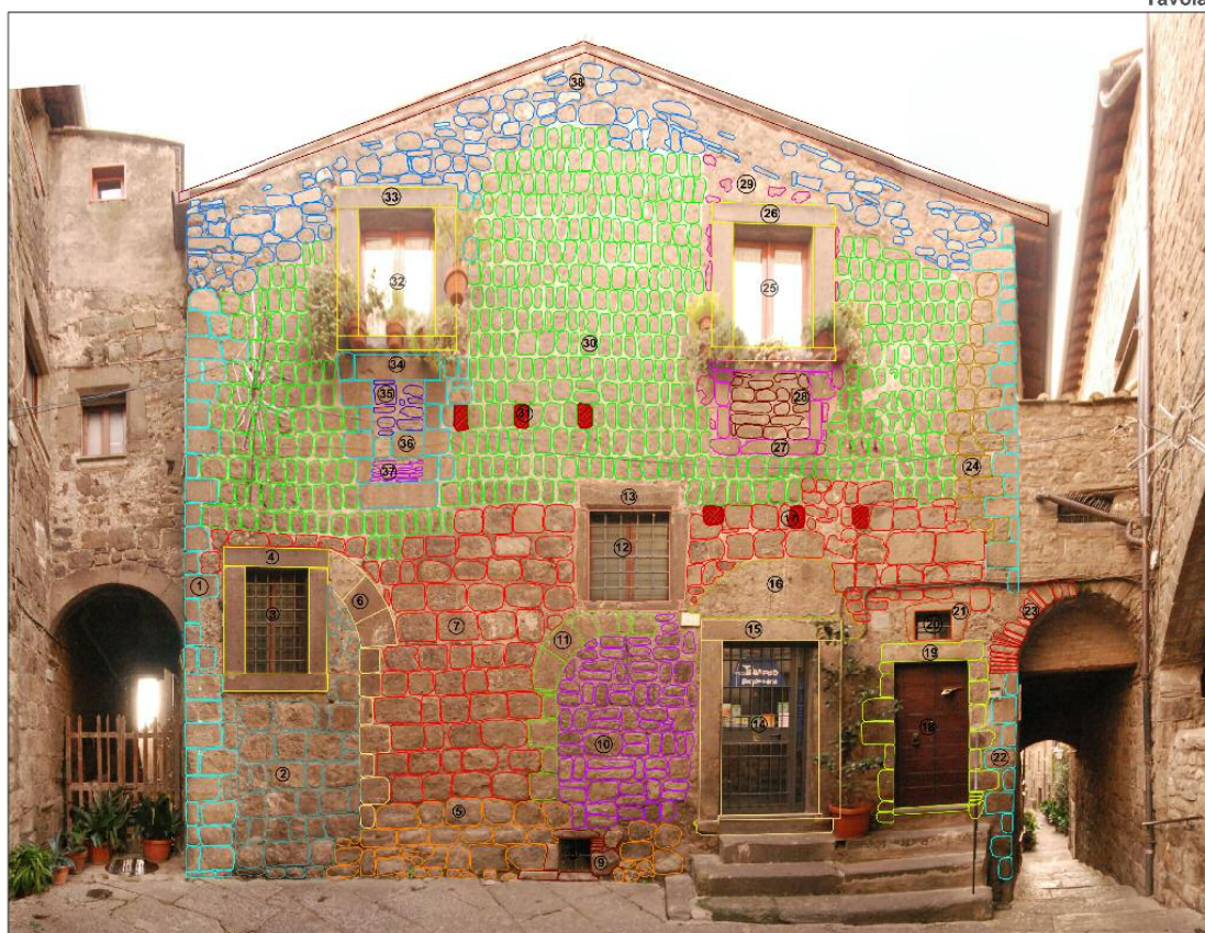
Fig. 2 - Fotoradrizzamento del prospetto dell'edificio con caratterizzazione delle fasi murarie.
