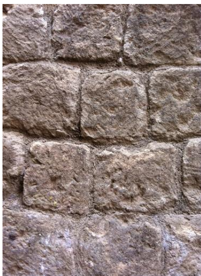
Fig. 10a - Muratura con malta di restauro, XII-XIII secolo (casa fig. 5, lato via Macel Gattesco).
