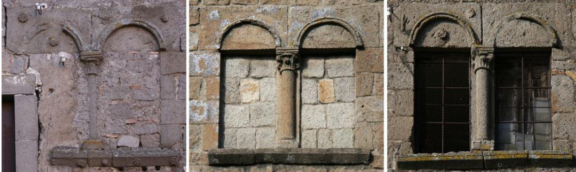
Fig. 9 - Bifore sulle facciate Nord-Est e Sud del palazzo.
