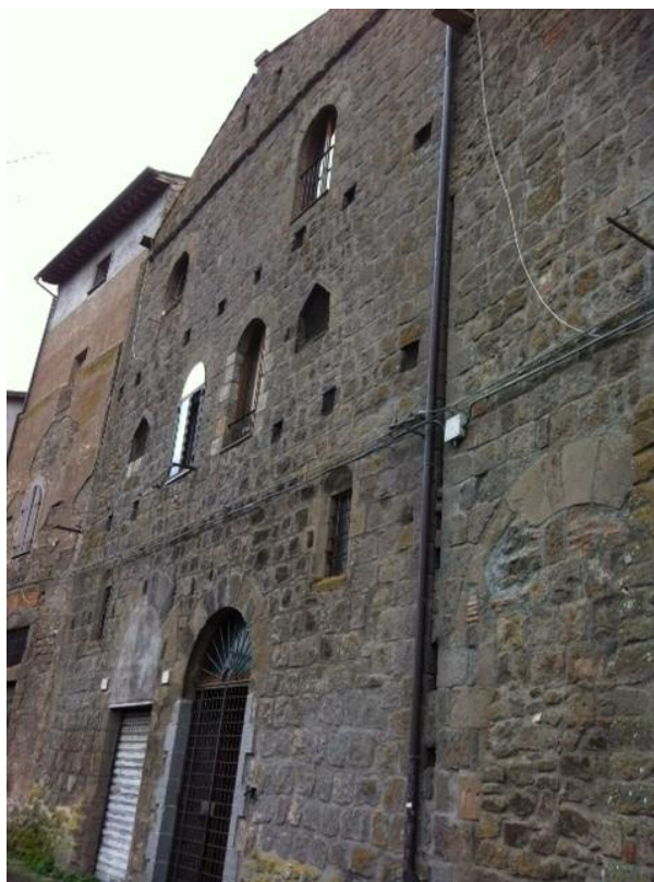
Fig. 8 - Casa in via S. Andrea-via delle Caprarecce a Piano Scarano, lato su via Caprarecce.
