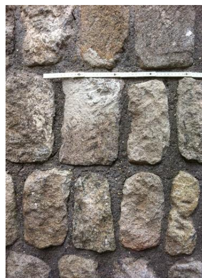
Fig. 10c - Muratura con malta di restauro, seconda metà XIII secolo (chiesa del Gesù).
