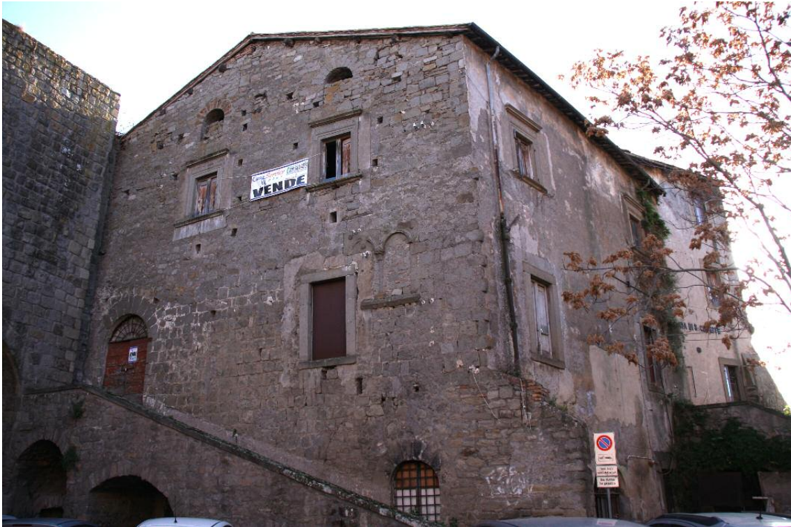
Fig. 3 - Veduta del complesso edilizio nelle sue condizioni attuali (da Nord).
