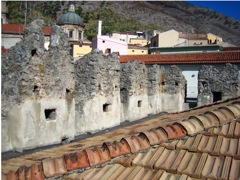
Fig. 18. Torre del mercato, i merli del coronamento visti dall'interno del terrazzo di copertura (foto S. Berardis).
