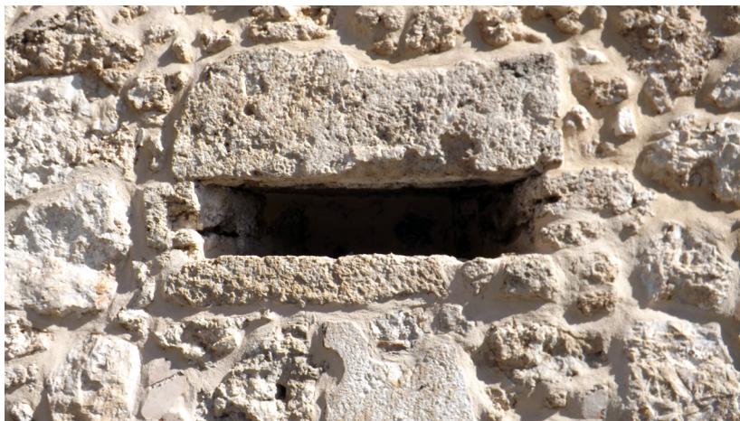
Fig. 12. Torre del mercato, la feritoia orizzontale del secondo registro, vista dall'esterno (foto S. Berardis).
