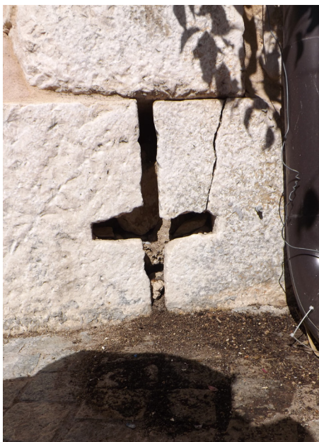
Fig. 14b. Torre del mercato, primo livello: parte superiore di una bombardiera verticale vista dall'esterno (foto A. Venditti).
