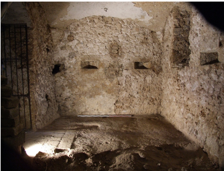
Fig. 17. Torre del mercato, le feritoie orizzontali del primo registro viste dall'interno del primo livello (foto S. Berardis).
